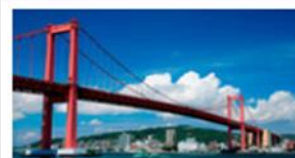
若松と戸畑を結ぶ若戸大橋
